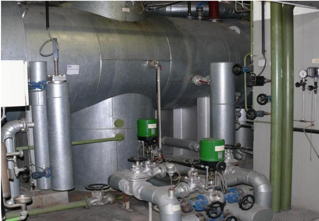
Bild 3.3: Kondensator Dampfturbine 1 (Heizkondensator)
