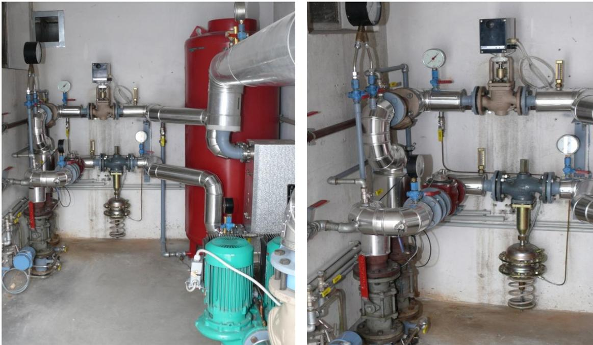
Bild. 5.1: Umformstation U 30 mit Wärmetauscher, Mengen/Differenzdruckregler, Durchregelventil, Wärmezähler, Fernwärmenetzpumpen und Ausdehnungsgefäß
