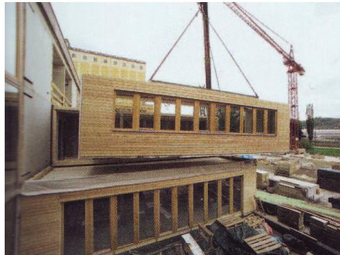
Abb. HR 08 Einheben der Module
