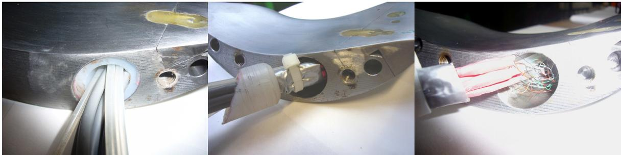
*Abbildung 4-17 Demontage des Verschlussstopfens*
