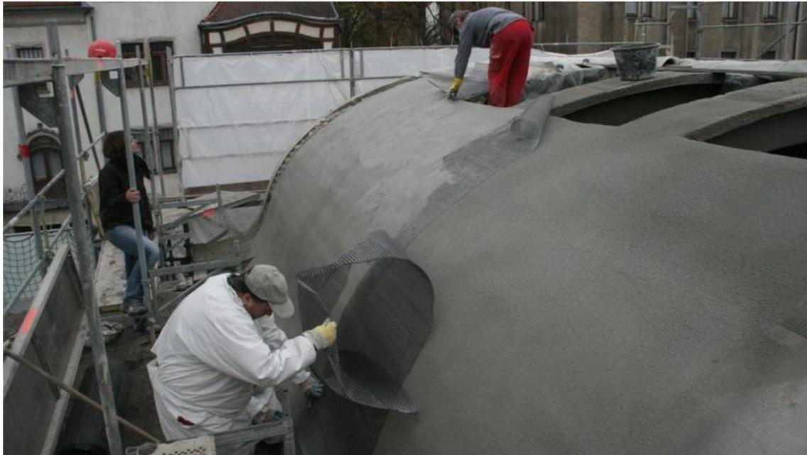
Abbildung 3.6: Verstärkung einer Tonnenschale in Zwickau.<sup>20</sup>
