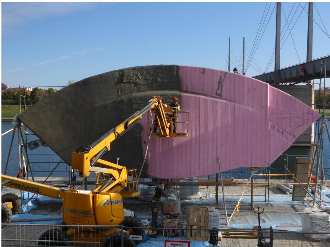
**Abbildung 10.20:** Herstellung der Betonhülle vor Ort.
