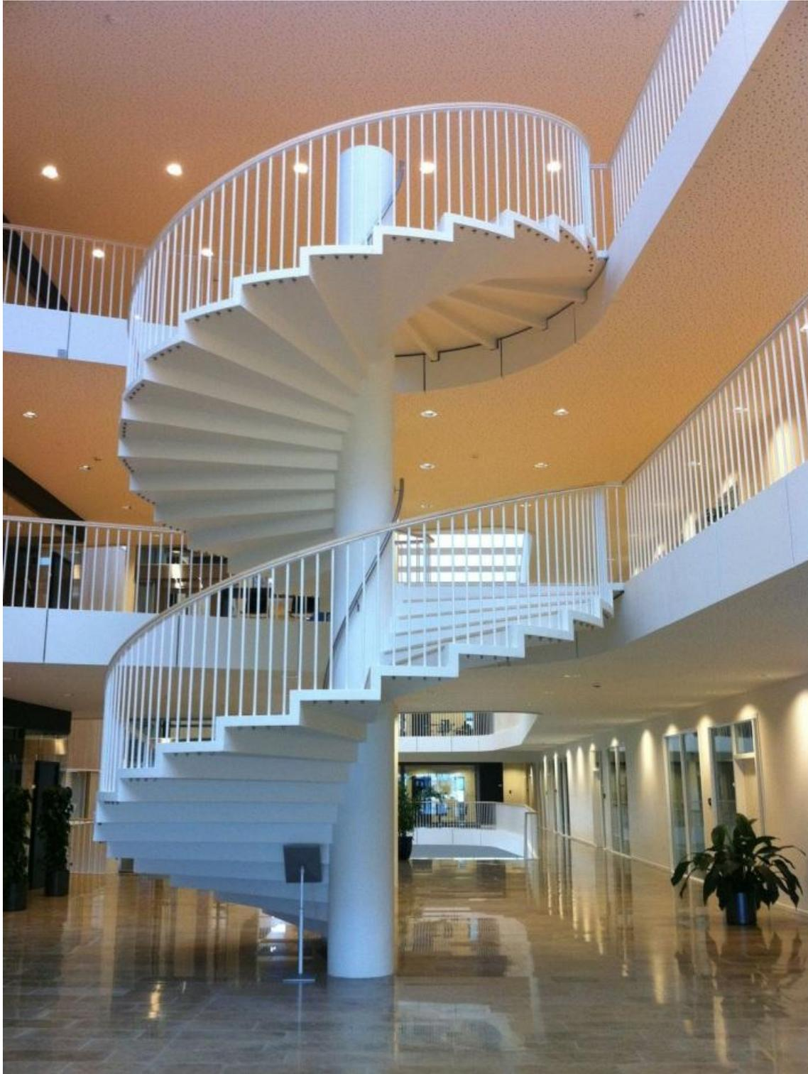
**Abbildung 4.8:** Dünnwandige Wendeltreppe aus weißem UHPC der Firma HICON / Dänemark (Copyright: HICON).<sup>42</sup>
