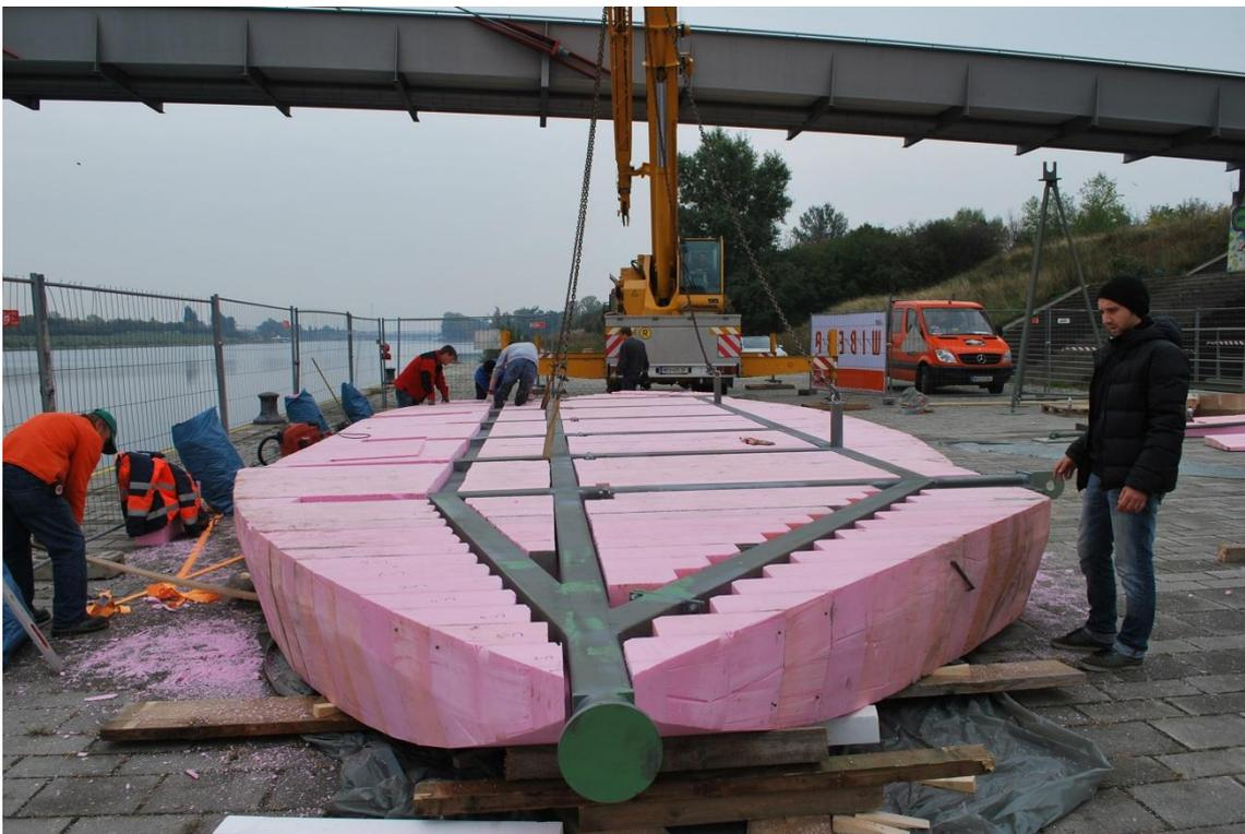
**Abbildung 10.19:** Grätenförmige Stahlkonstruktion im Inneren des XPS-Körpers.
