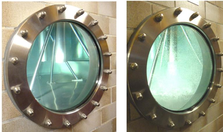
Abbildung 20: Ozonung außer Betrieb (li) und Ozonung in Betrieb (re) (Fotos: Gruber, 2013)
