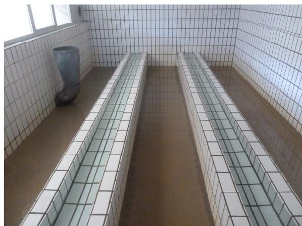
Abbildung 21: Quarzsandfilter nach Ozonung (Foto: Gruber, 2013)
