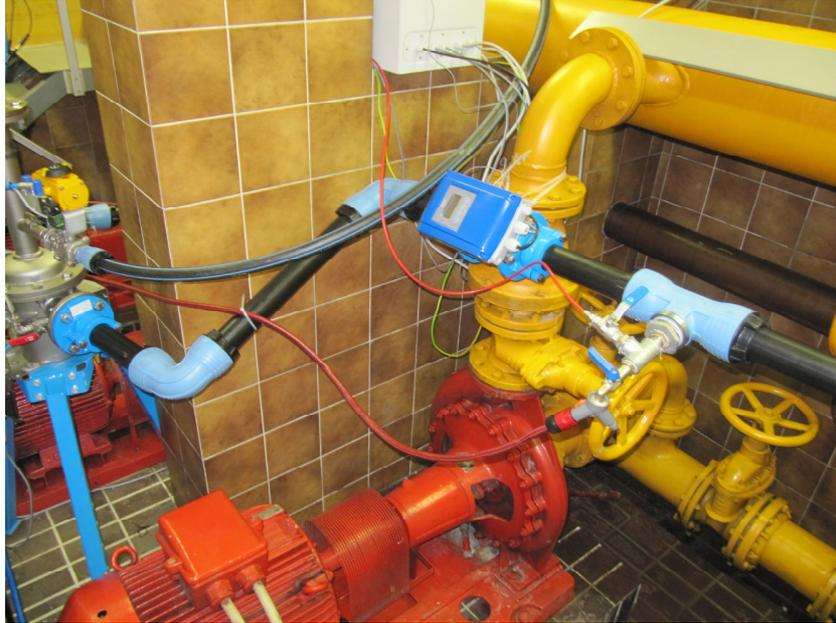
Abbildung 32: Nachträglicher Einbau 2-Wege Verteiler - Probenahmeahn Zulauf
