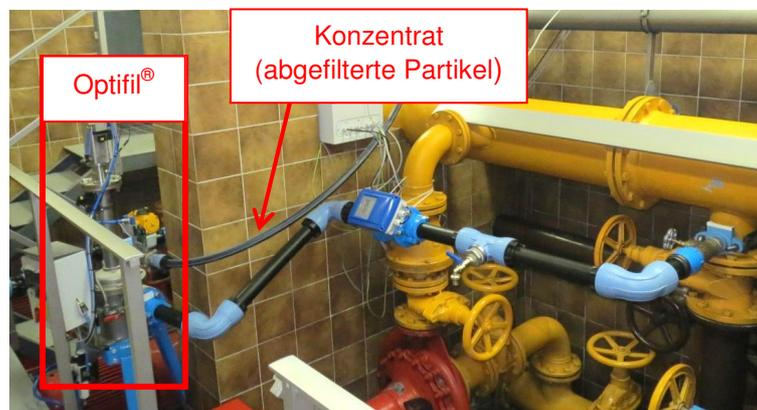
Abbildung 29: Versuchsaufbau - Optifil im Bypass mit Konzentratablauf
