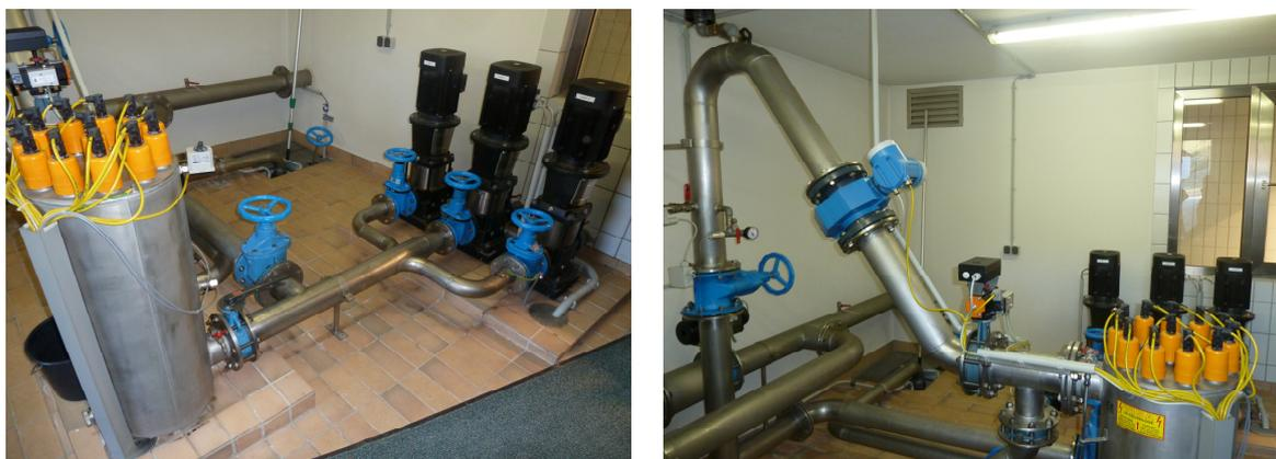
Abbildung 17: UV-Desinfektion mit Pumpen und Zu- und Ablaufleitung (Fotos: Gruber, 2013)
