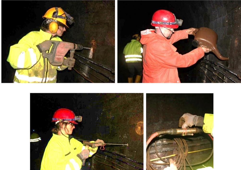
Abbildung 27: Elektrodenmontage in den Ulmen von links oben nach rechts unten: Bohren der Befestigungslöcher, benetzen der Löcher mit Stollenwasser, anbringen der Elektrodenspitze, Positionierung der Elektroden auf den Metallspießen.
