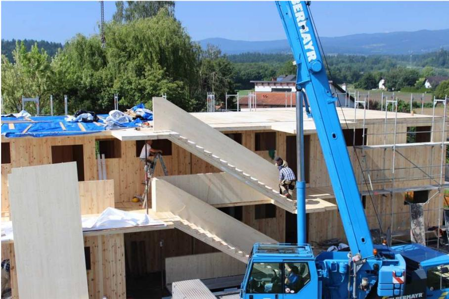
Abbildung 3.17: Montage des Treppenaufganges
