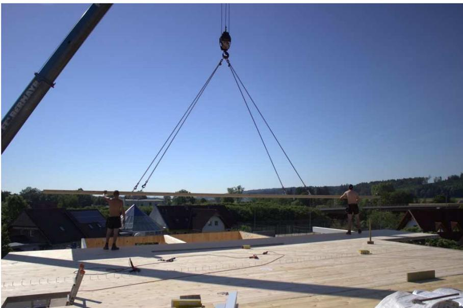
Abbildung 3.23: Montage eines BSP-Dachelementes
