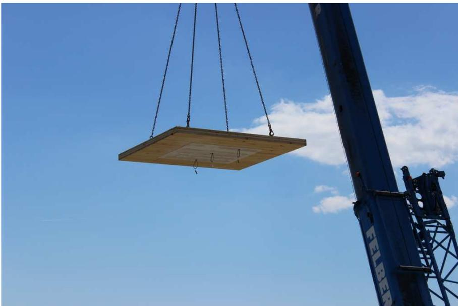
Abbildung 3.20: Montage des BSP-Liftschachtdeckenelementes mit zusätzlich angebrachten Schlaufen für die spätere Liftmontage
