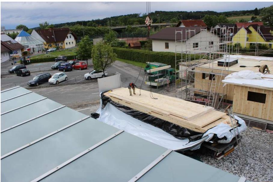
Abbildung 3.25: Anhängen der BSP-Elemente am Sattelanhängen
