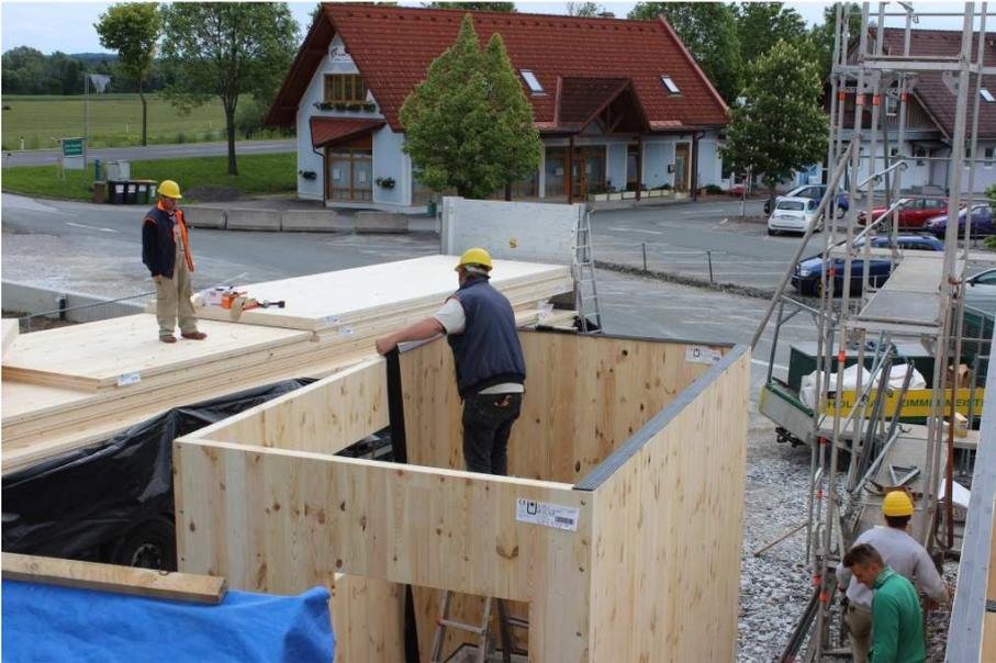
Abbildung 3.12: Stirnseitiger Einbau des Schallschutzbandes am Beispiel der AW des Technikraumes
