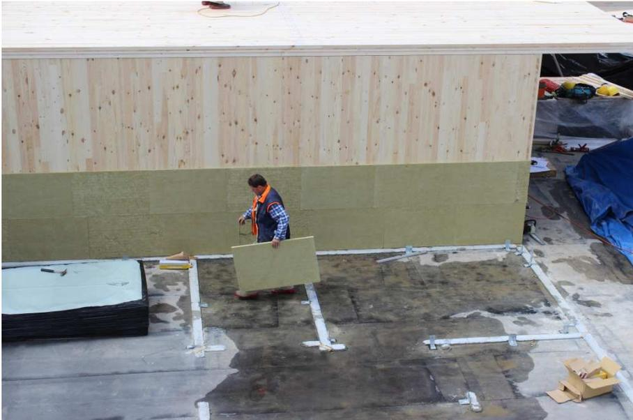
Abbildung 3.16: Anbringen der Dämmung (Mineralwolle) an der Wohnungstrennwand
