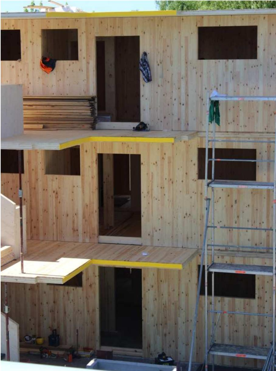
Abbildung 3.18: Schalldämmtrennlage an den Stirnseiten der Deckenelemente
