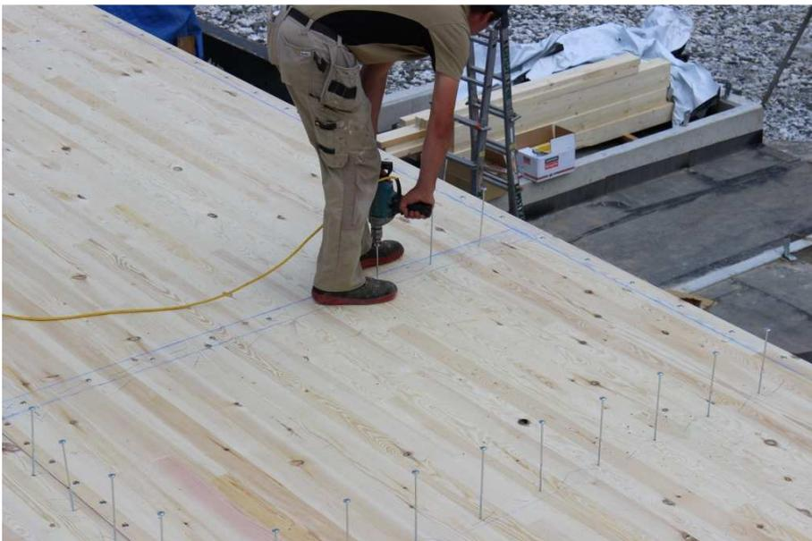
Abbildung 3.15: Verschraubung der Decke über EG
