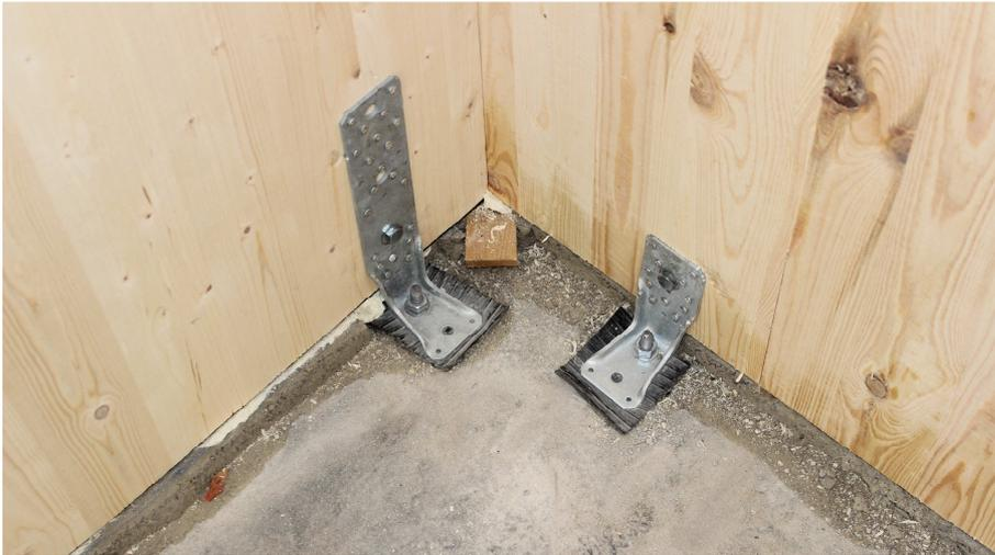
Abbildung 2.42: Winkelverbindung BSP zu Beton (rechts der Winkeltyp KR 135)
