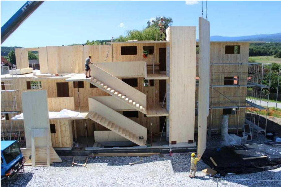
Abbildung 3.19: Montage des westseitigen BSP-Liftschachtelementes
