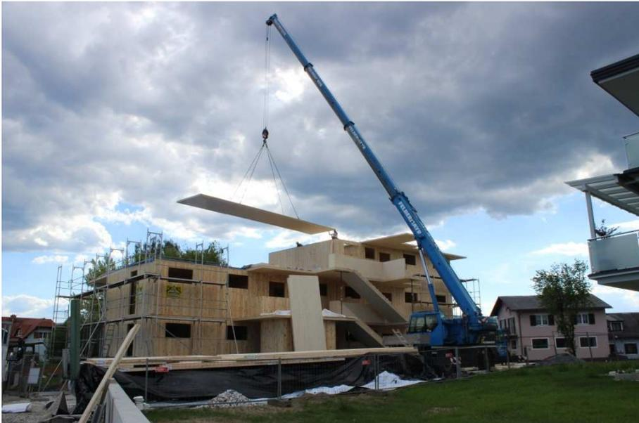
Abbildung 3.22: Hubvorgang für Montage der BSP-Dachelemente
