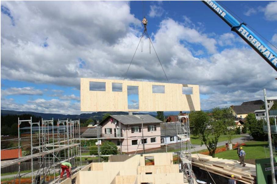
Abbildung 3.10: Positionieren der nordseitigen AW im EG
