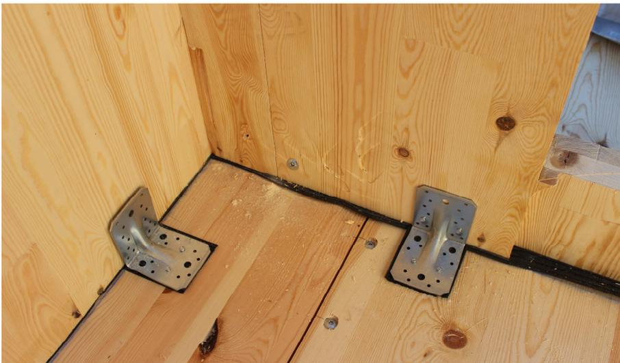
Abbildung 2.43: Winkelverbindung BSP zu BSP (Winkeltyp 90 mit Rippe)
