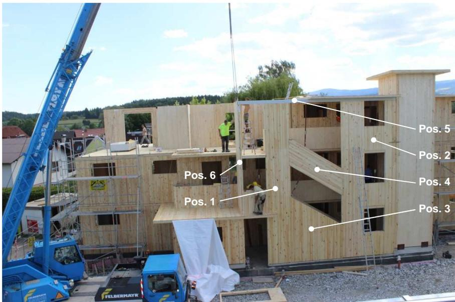
Abbildung 3.21: Außenverkleidung des Treppenaufganges
