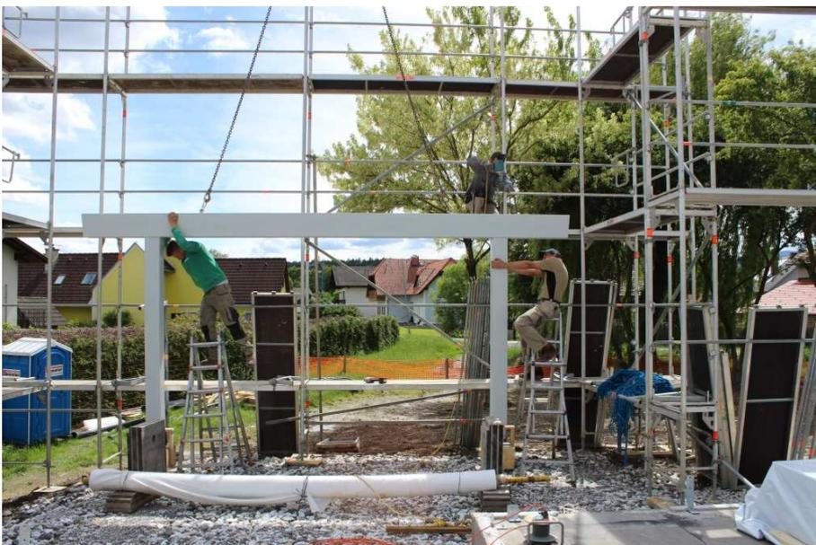
Abbildung 3.11: Montage der Unterkonstruktion bestehend aus Stützen und Unterzug für die weitere Deckenauflagerung
