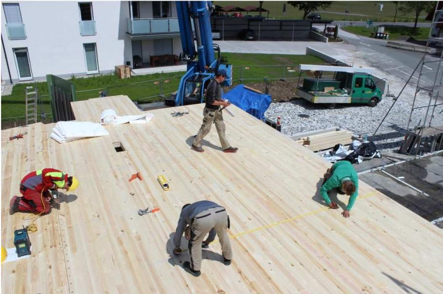
Abbildung 3.14: Einmessen der Decke über EG mit dem erforderlichen Schraubenanstand, sowie der Achsen für die Wände des 1.OG
