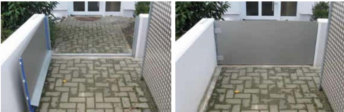
Abbildung 23: drehbare Gartentür Typ WHS; links offen und rechts geschlossen (<http://www.mehochwasserschutz.at/Hochwasserschutz-Beispielfotos/hochwasserschutz-tueren.htm>)
