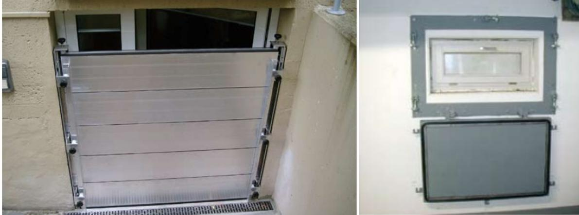
Abbildung 22: Dammbalkensystem für eine Eingangstür und eine Fensterdichtklappe (Schönfelder et al., 2012)
