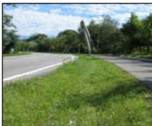
Bei einer Muldenversickerung wird das anfallende Regenwasser in einer Grasmulde mit einer max. Tiefe von 30 cm gesammelt und natürlich versickert.
