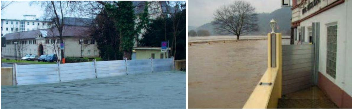
**Abbildung 4: Beispiel für einen Objektschutz in Form von Dammbalkensystemen (Ruiz et al., 2010)**
