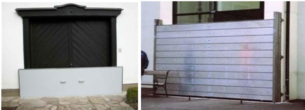
**Abbildung 24: Garagentore links mit WHS System und rechts mit einem Dammbalkensystem DPS 2000 (<http://www.me-hochwasserschutz.at/Hochwasserschutz-Beispielfotos/hochwasserschutz-tore.htm>)**
